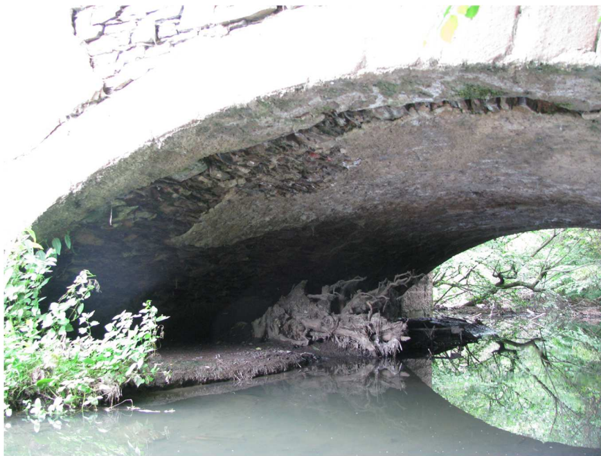
Foto č.12 - Pohled pod most po směru toku s viditelným poškozením klenby.
